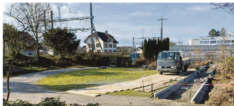
Bauarbeiten sind im Gange: Hier wird das neue Grabfeld angelegt.
