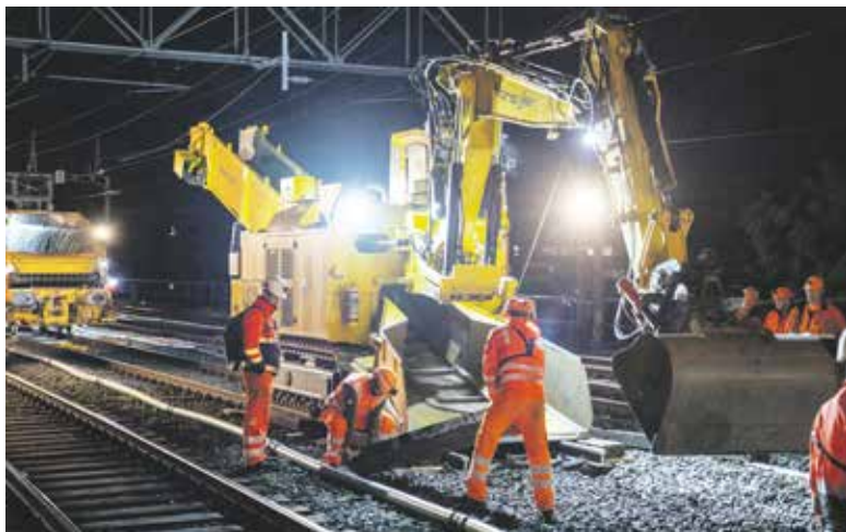
Mitarbeitende der SBB bei nächtlicher Gleisarbeit.
